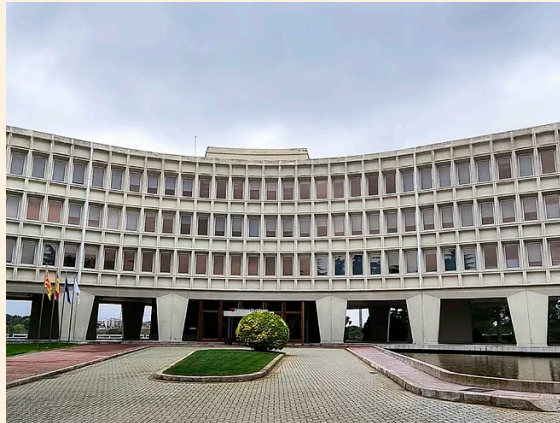
Sede de GCO en San Cugat. EXPANSION
